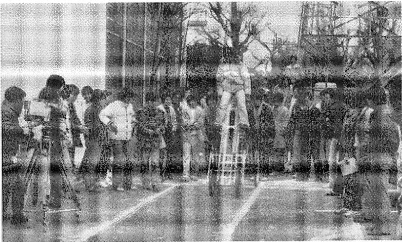
3年次学生「制御設計製作」のコンテスト風景 乾電池2個を使い人を乗せてできるだけ速く走る乗物を作れ、というテーマで4組が実物を設計製作して競い合う（昭和57年2月）
