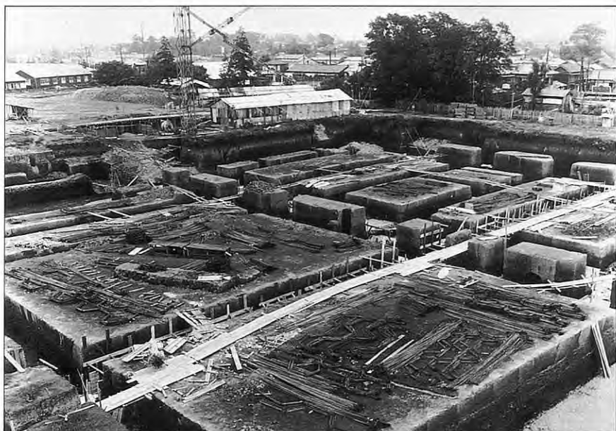
本館建設基礎工事
