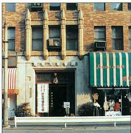
本学同窓会館・蔵前工業会館
