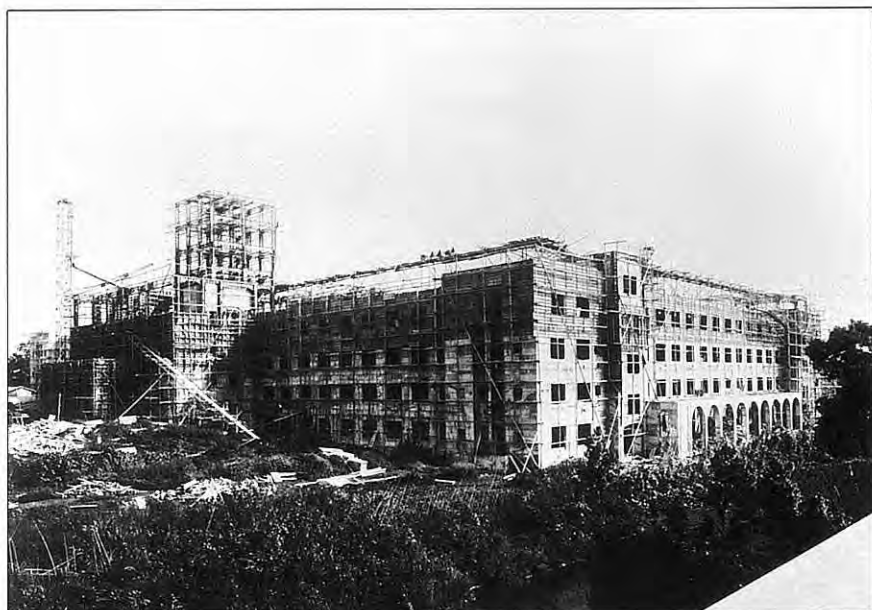
枠組みをはずした本館
