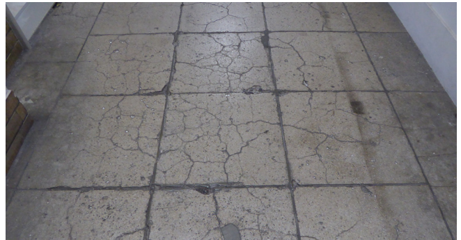
② 旧々図書館の廊下。図1の赤ポイント
