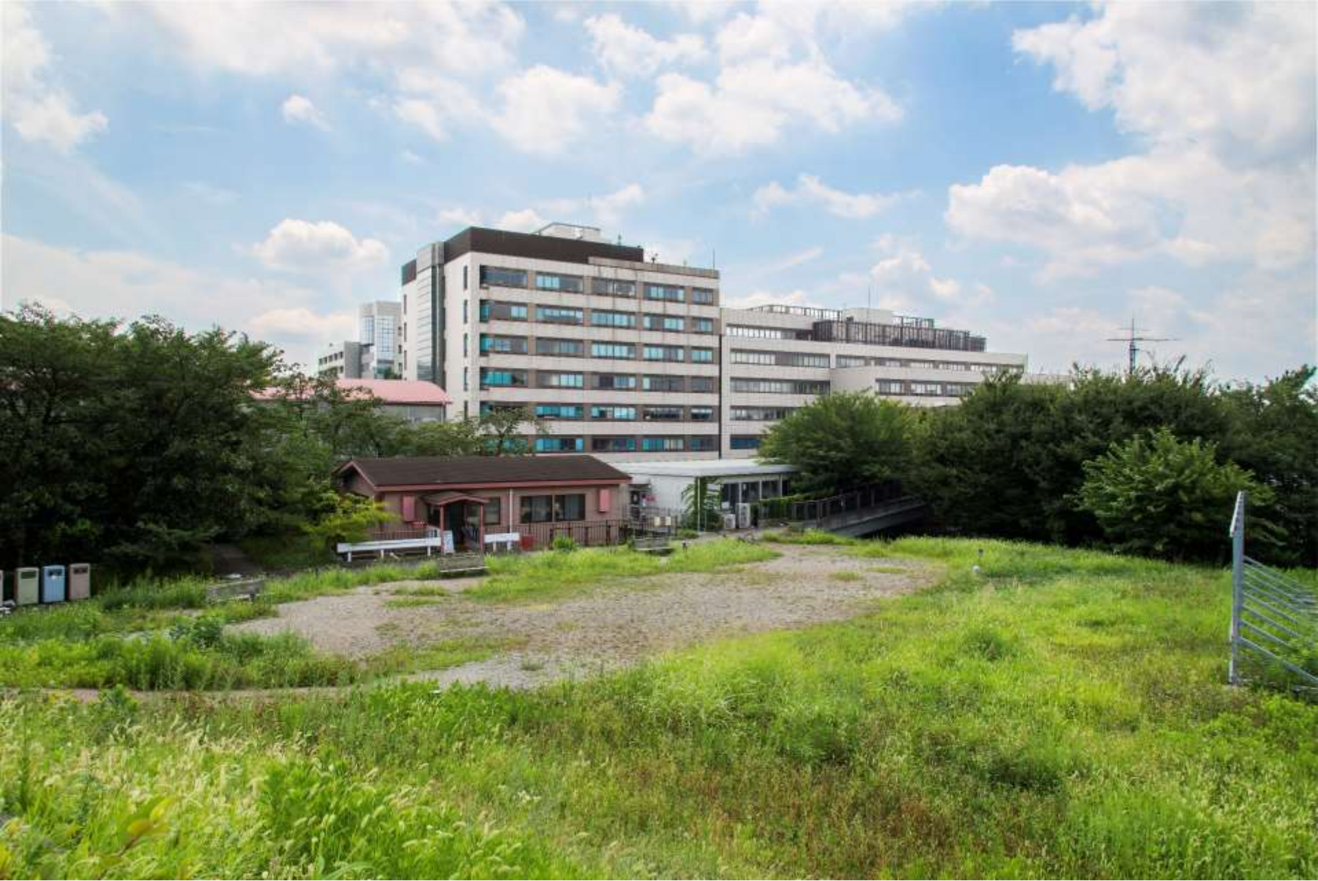
8_DSC_1165_線路脇からW9号館
