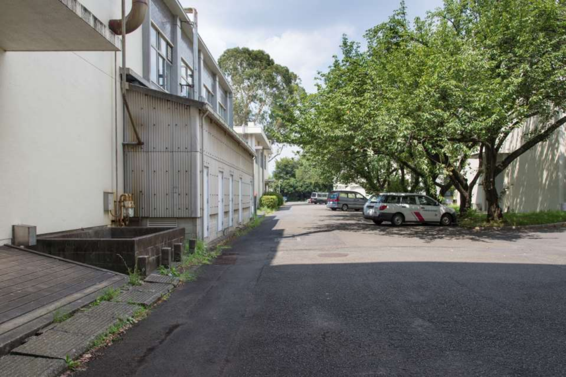
4_DSC_1186_北地区(2号館下 吹抜から)
