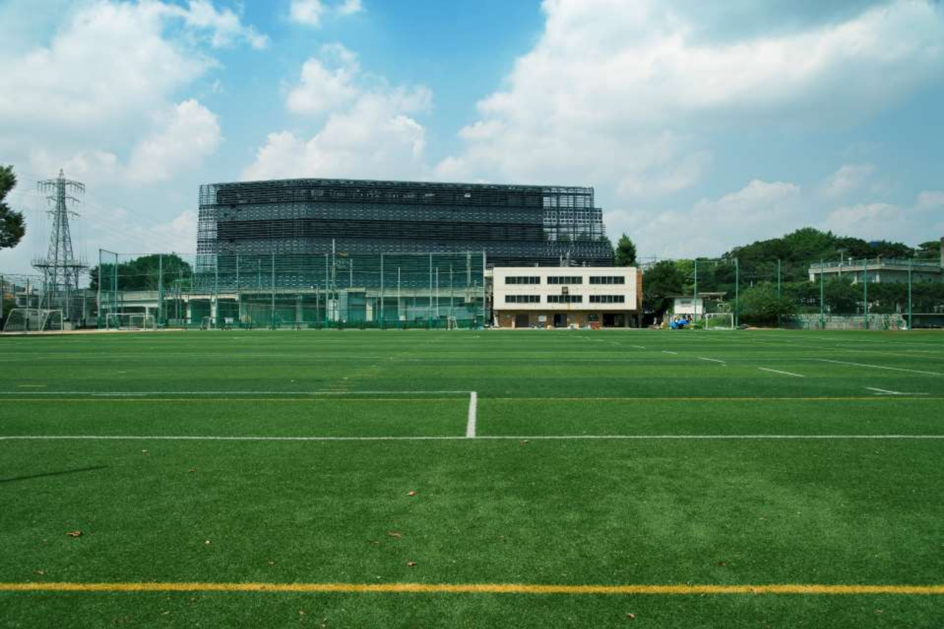
15_DSC_1179_グラウンドからEEI棟
