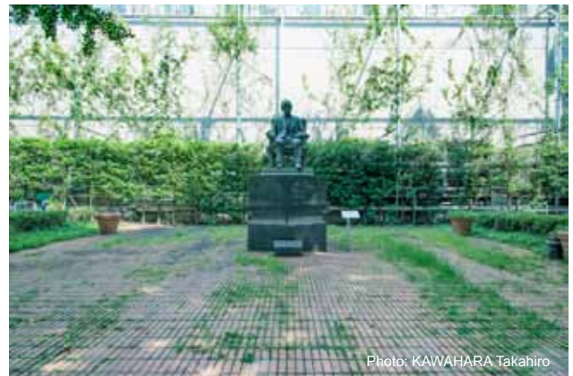
⑤ GSIC の外壁とスパコンの冷却配管；手前は手島精一像。
