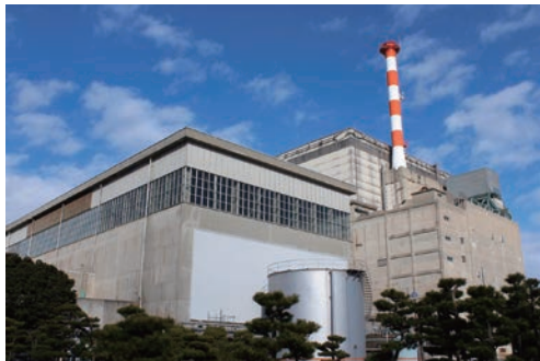
東海発電所 日本原子力発電提供
